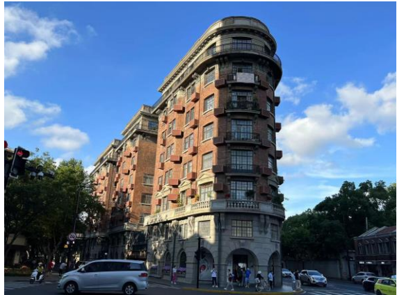
人気撮影スポット 武康大楼 (現在もマンションとして使用されている)
